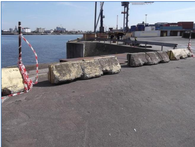
„Verstärkte / größere Betonsteine“ zur Absicherung der Wasserseite sind geeignet.
